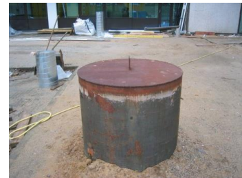
Figuur 14 Stalen hoed t.b.v. tijdelijke bronafwerking
